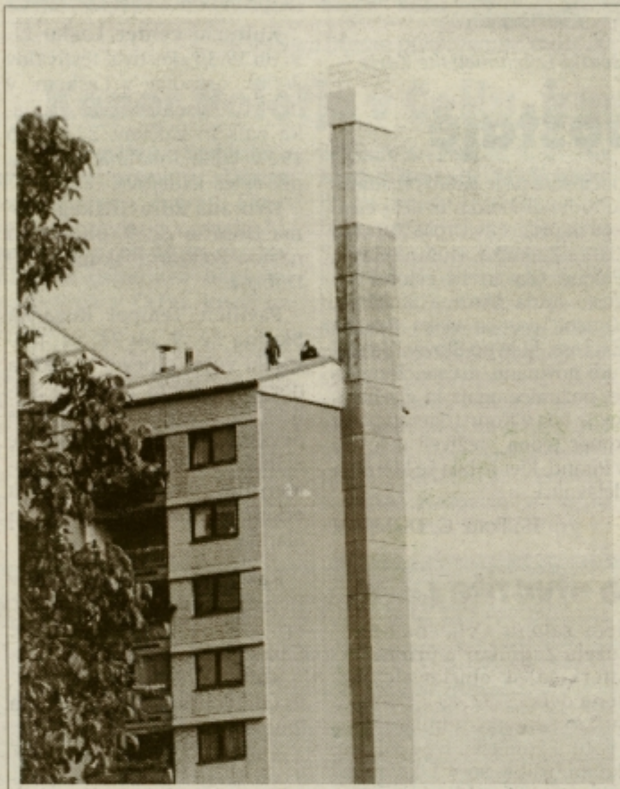
Očiščen dimnik na enem od blokov v Novi vasi je pripravljen na kurilno sezono, ki bo letos še dodatno praznila žepce.
