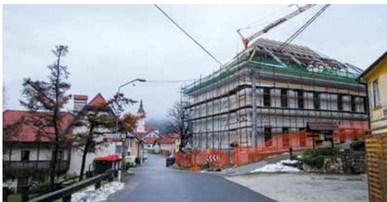
Gradbena dela na bodoči Hiši kranjske čebele v Višnji Gori, 2020
