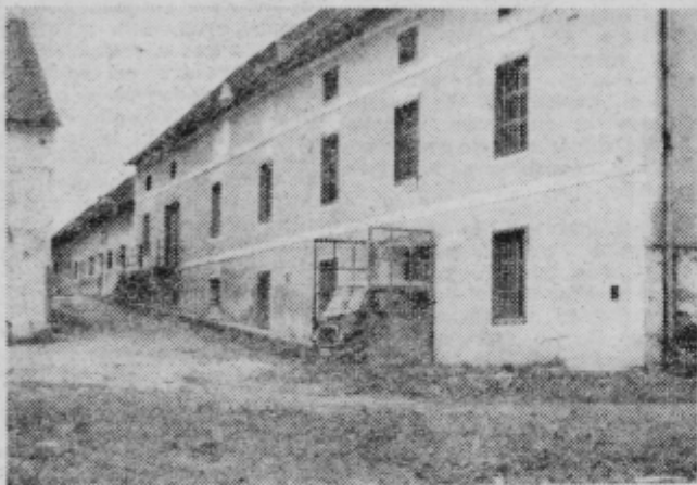
Droga Portorož obrat in odkupna postaja Središče
