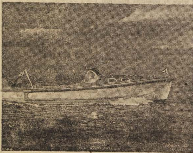
Na sliki vidimo steklen motorni čoln, dolg 7,9 m. Izdelali so ga po načrtih angleške admiraltete in ga vili v enem kosu. Tvrška Halmatic lahko izdela iz steklenih vlaken poljuben čoln do dolžine kakih 30 m, torej tudi manjšo jahto
