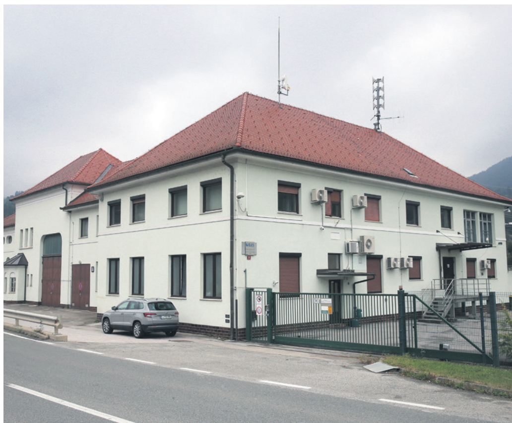
Zbirki pisalnih strojev in starih radijskih sprejemnikov se v okviru muzeja elektroprenosa nahajata v stavbi RTP Laško, prve razdelilno transformatorske postaje v Sloveniji in nekdanji Jugoslaviji.
