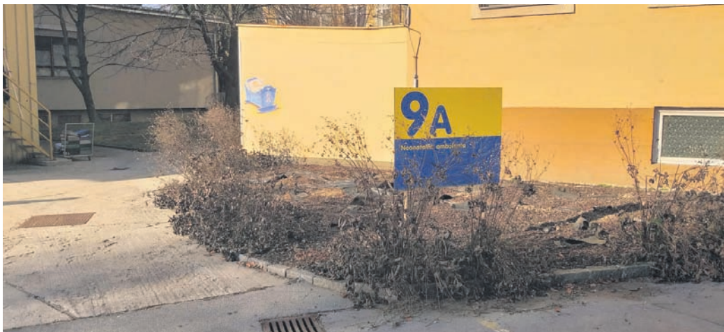
S postavitvijo gradbišča bo med gradnjo zaprt tudi vhod št. 9 A, namenjen dostopu do neonatalne ambulante. Dostop do te ambulante bo skozi glavni vhod na ginekološko-porodniški oddelek, tj. vhod št. 9. Vendar se ginekološko-porodniški oddelek ne bo smel uporabljati za vhod bolnikov z ostalih oddelkov niti zaposlenih v drugih delih bolnišnice.
