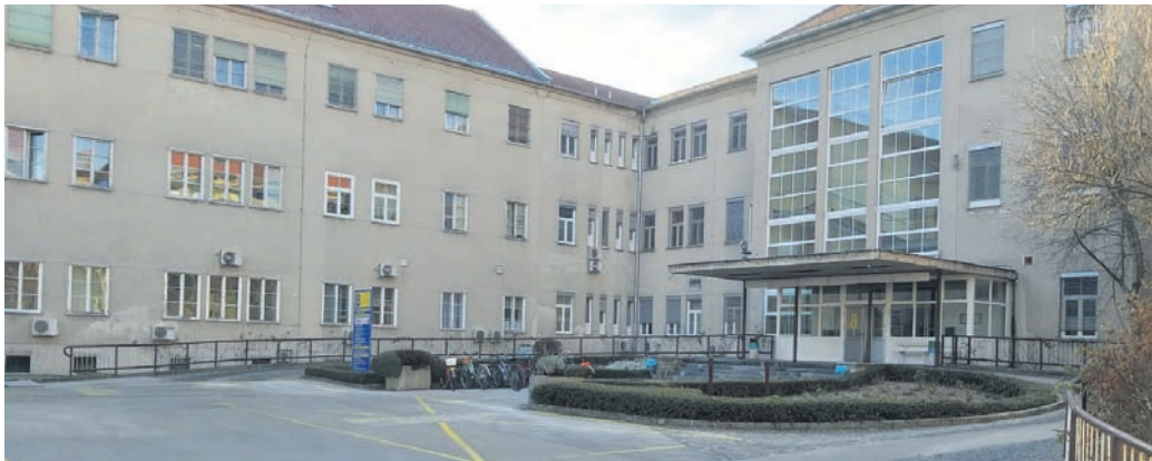
Vhod št. 8, ki je vhod v najstarejši objekt celjske bolnišnice, t. i. Gizelino bolnišnico, bo ves čas gradnje dostopen, vendar bodo ob njem močno omejene vozne in ostale proste površine. Te bodo omogočale samo dovoz in odvoz bolnikov, a ne parkiranja, zato bodo morali vsi, ki bodo pripeljali svojca na obravnavo ali prišli ponj, območje z avtomobilom takoj zapustiti.
