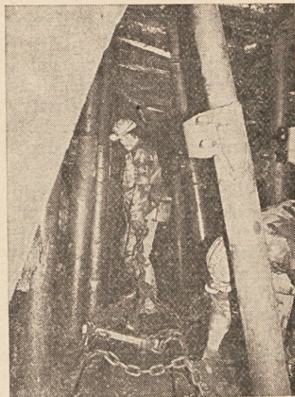
Montaža verige v transporter na odkopnem čelu v jami TOZD Premogovnik Trbovlje.
