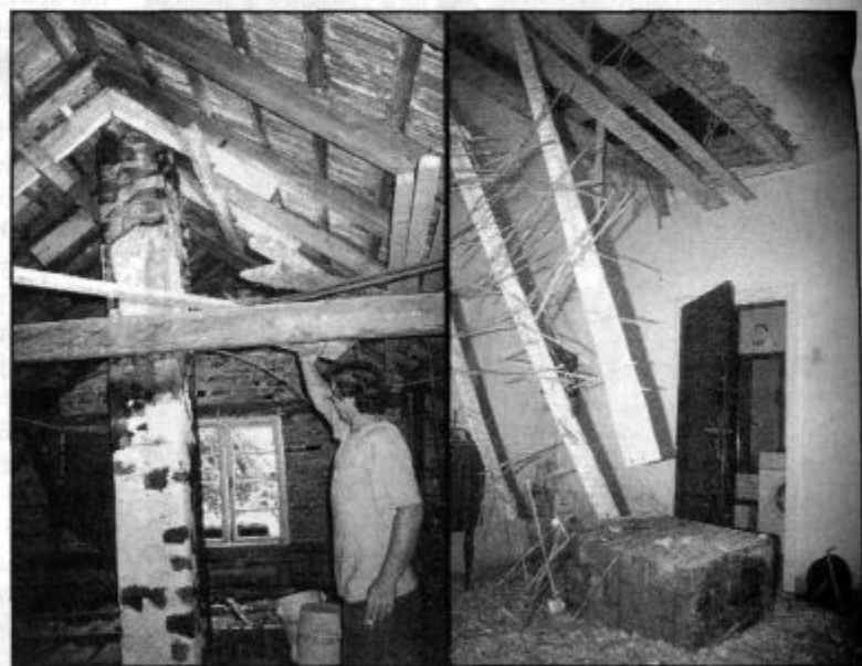
Ramiz Ribič nam je nekaj dni preden je dimnik zgrmel v njegovo spalnico kazal, v kakšen stanju je. Ob naslednjem obisku smo lahko poslikali drugi prizor - luknjo v stropu in dimnik na tleh. Tudi Kladnikovo stanovanje je bilo v zelo slabem stanju, sploh kopalnica, kjer je nezaščitena električna omarica.
