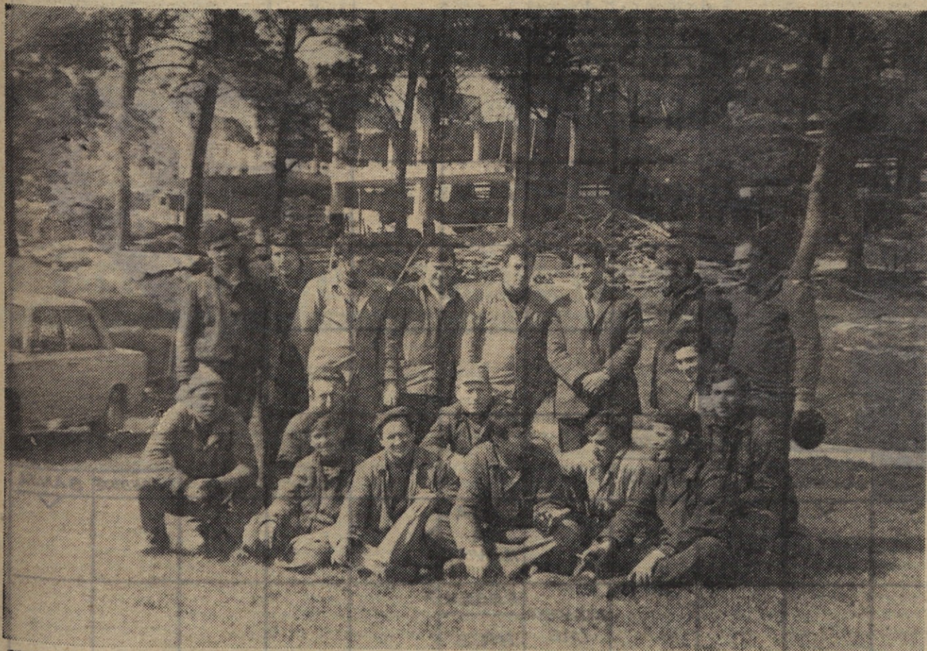
Skupina naših monterjev iz Kopra s tov. Rožmanom, šefom montaže, pred novogradnjo hotela »Parentium« v Poreču
