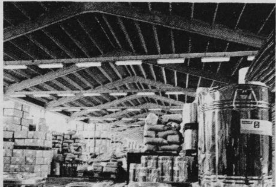
Gradis je kot izvajalec znan tudi pri gradnji montažnih železobetonskih hal. Eno tako je postavil tudi v Celju. To je Aerovo skladišče gotovih izdelkov.
