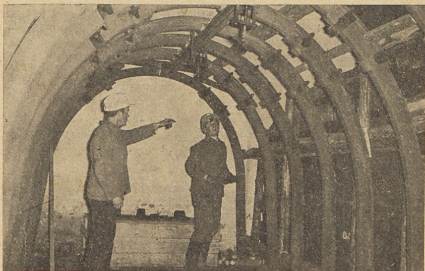
A PROGRAM — postavljanje TH podporja.
