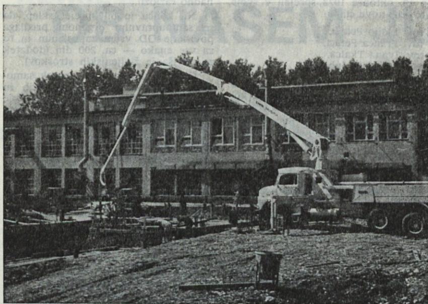
Betoniranje temeljev v septembru
