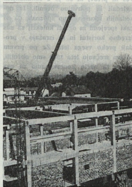
Montaža nosilcev konec oktobra
