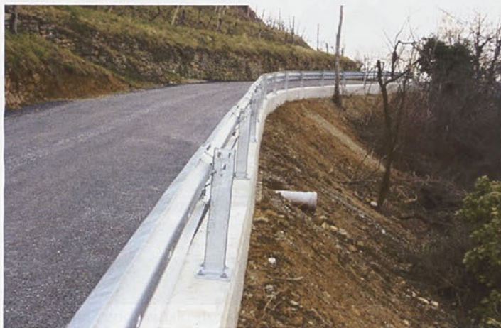
Pogled na sanirani plaz na lokalni cesti Turški Vrh–Hrastovec
