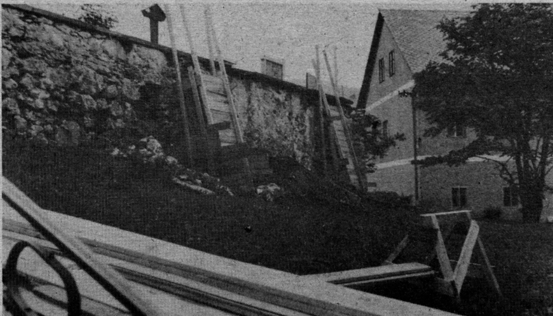
Pokopališko obzidje v Novi Štifti je na nekaterih mestih zelo slabo. Krajevna skupnost ga sedaj obnavlja. Dela so zahtevna, vendar pa nujno potrebna
