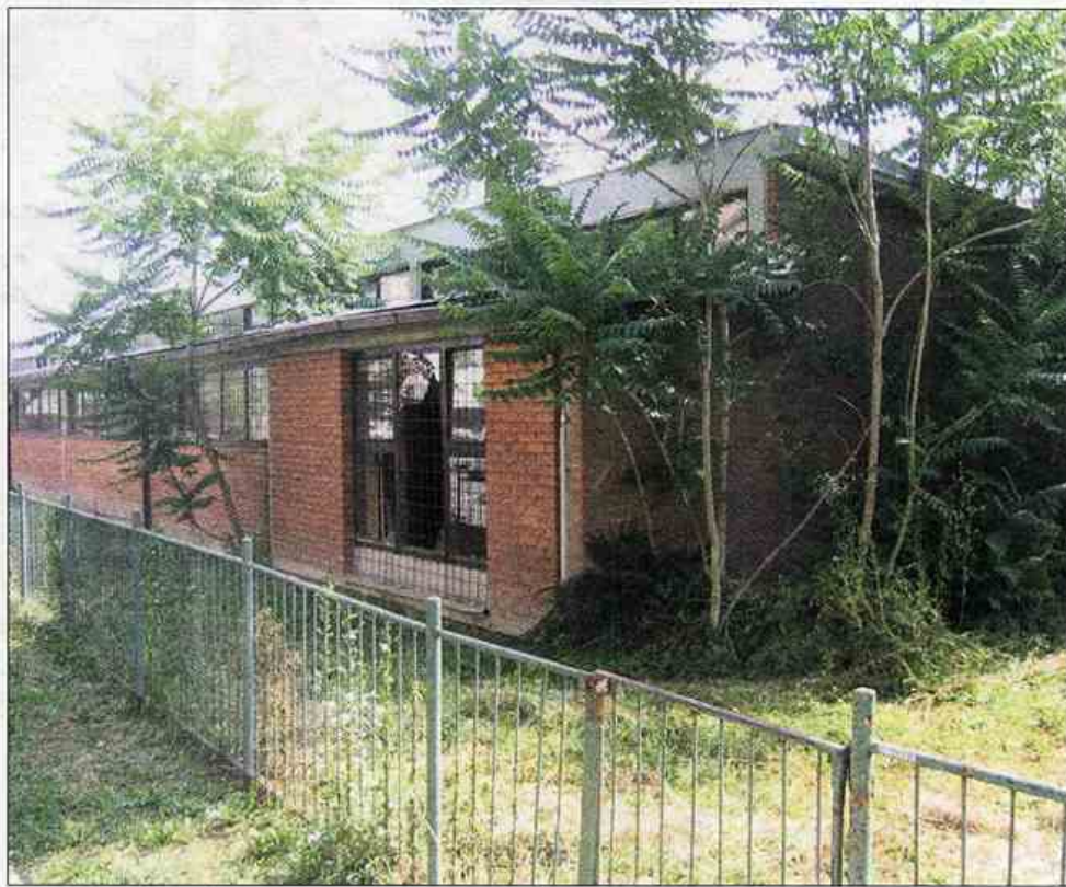
Prostor v Drapšinovi ulici bo do nadaljnjega še naprej zasedala podrtja opuščene vrtca.
