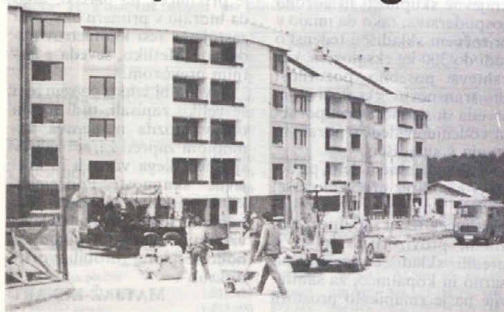
Zunanja ureditev bloka H — asfaltiranje
