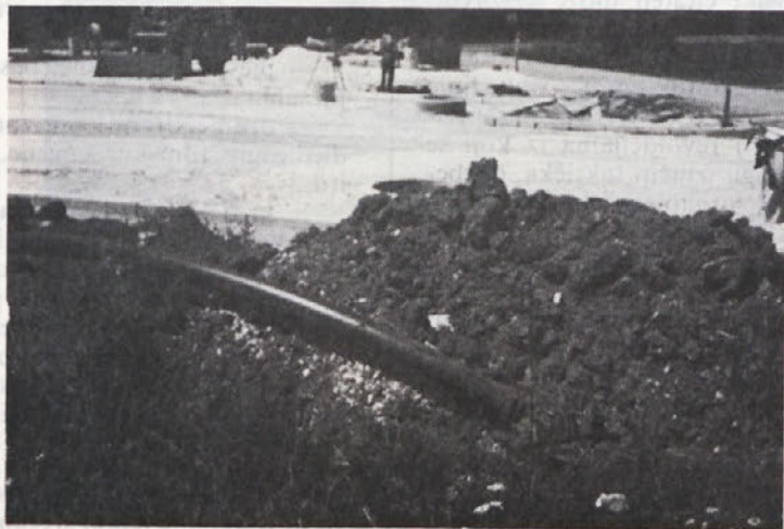
Delavci TOZD MKI so se s svojim prispevkom uključili v akciju (položitev in montaža hidranta na Cikavi) in s tem zmanjšali stroške za investicijo. (Foto: Borsan)
