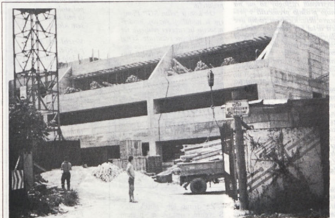
Gradnja 1. faze pralnice in energetike, investitor Zdravstveni center v Novem mestu. Gradi TOZD Novo mesto, vodja gradbišča Anton Graberski, dipl. gr. inž.
