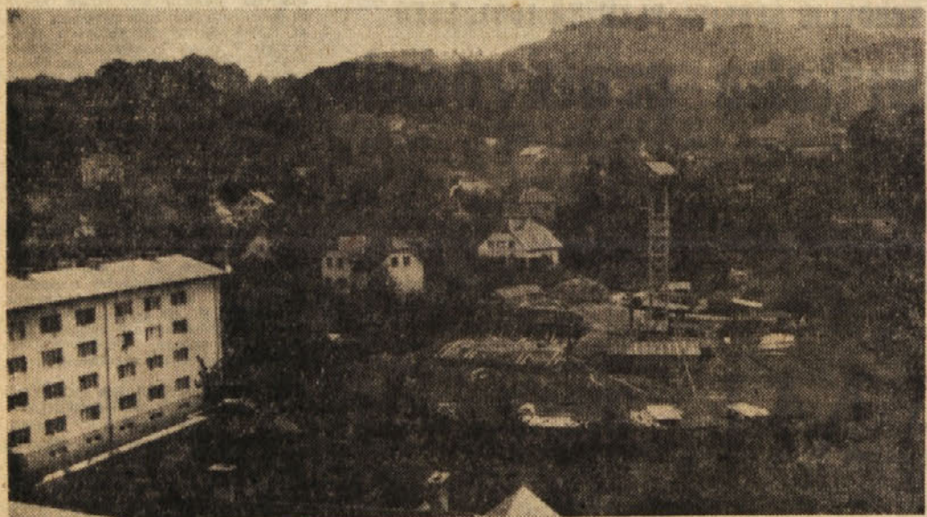
POGLED NA GRADBIŠČE NA BREZNIKOVEM, KJER GRADE ZDRUŽENI INVESTITORJI TRI STOLP-NICE. DELO IZVAJA SPLOŠNO GRADBENO PODJETJE »ZASAVJE« IZ TRBOVELJ
