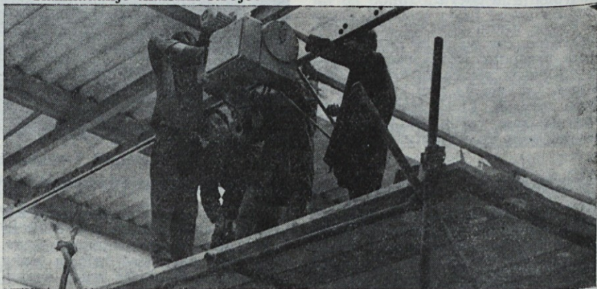
Montaža tovornega dvigala v novi škroblilnici
