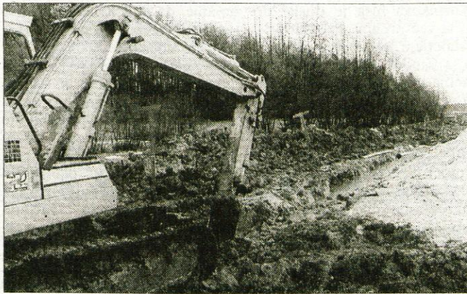
Na zahodnem delu občine Cerklje že rijejo gradbeni stroji.
