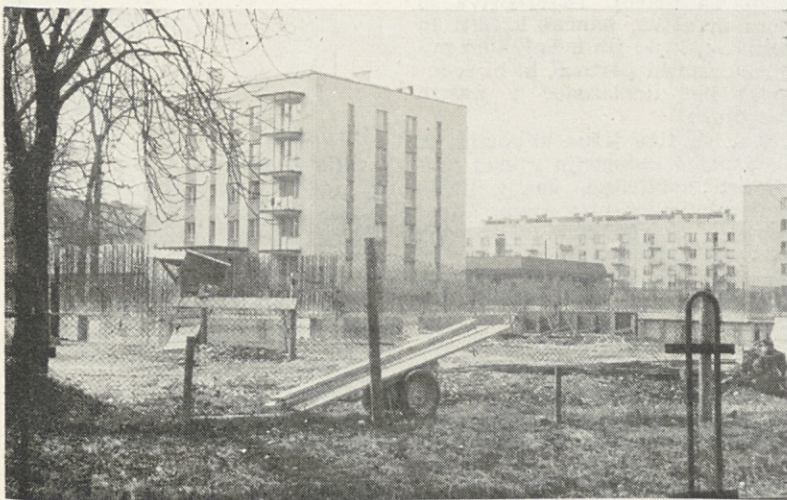
Zadnji blok na sedanjem gradbenem območju je že pogledal iz zemlje
