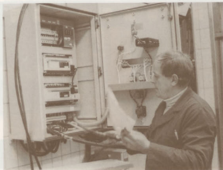
Delo pri montaži opreme v klavnici
