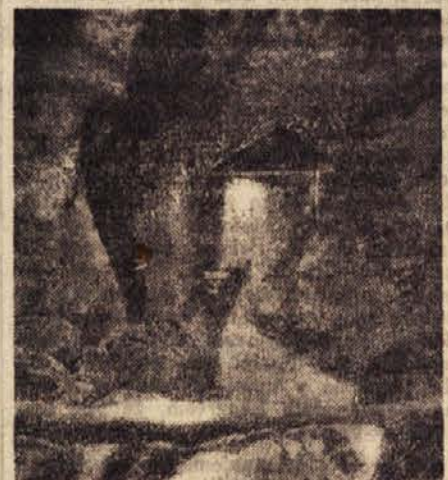
Cerkno pri Idriji — bolnišnica »Franja«, objekt elektrarne na dnu prepada nad hudournikom. Elektrarna je prilepljena na steno.
