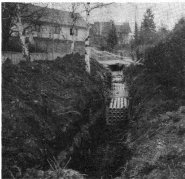
Pretekli petek popoldne: izkopani jarek s cevmi PTT kanalizacije poleg križišča pri Podmornici.
