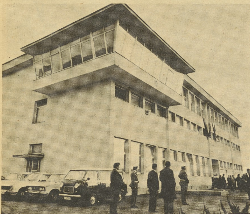
Center za daljinsko upravljanje prometa in elektro vleke v Rajlovcu.
