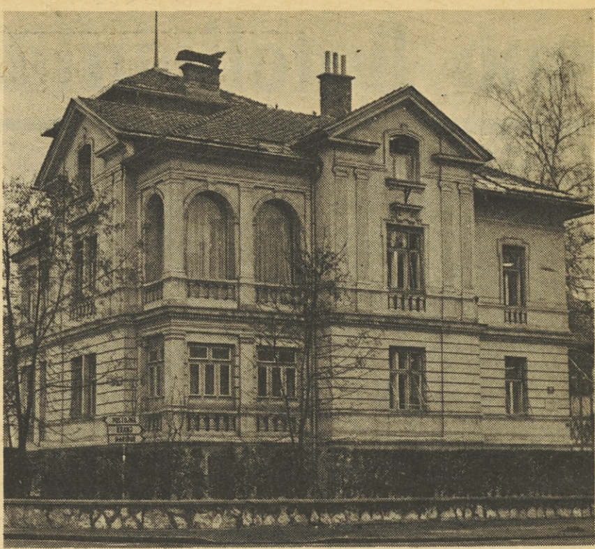
Sedež direkcije avtomatike in sektorja za avtomatizacijo prometa v Ljubljani, Prešernova 27, kjer so se porajali načrti za modernizacijo železnic.
