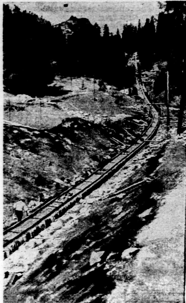
Una linea ferroviaria nelle Alpi svizzere — Švicarska gorska železnica
