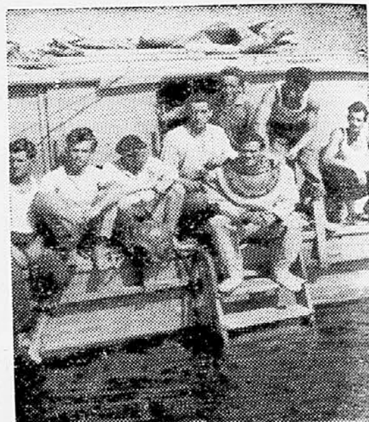
POSEBNO TEŽKO IN ODGOVORNO DELO STA IMELI SKUPINI, KI STA BETONIRALI PODVODNE STEBRE. PRI TEM DELU SO OPRAVILI NAJTEŽJE NALOGE POTARLJACI IVICA JURIC, IVAN GASPERINI IN VLADO ANTULOVIC. NA SLIKI: IVICA JURIC SREDI SVOJIH SODELAVCEV.
