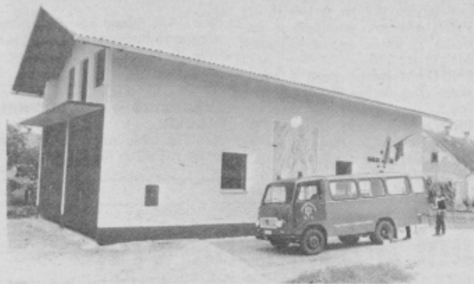
Biški gasilci so najbolj ponosni na dozidan in prenovljen gasilski dom. (foto: M. Ozmeč)
