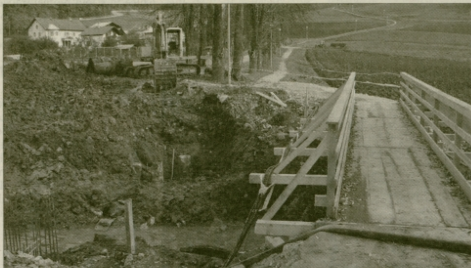
Nadomestni most čez Slomškov potok je zaenkrat zgolj gradbena jama. Krajanje pa skrbijo, kako bo s prometno varnostjo pozimi, saj je prehod preko potoka mogoč le po ozkem mostičku, ki se konča skoraj neposredno na cesti, po kateri je zaradi lokalnega obvoza zdaj občutno gostejši promet.
