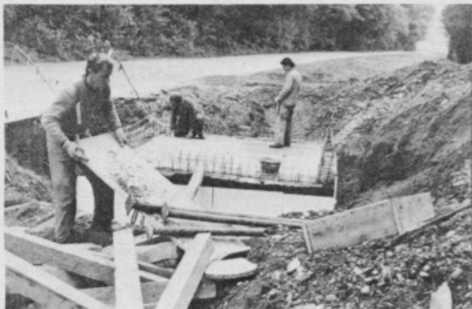
Vodovodna povezava med Ptujem in Mariborom je opravljena, sedaj potekajo le še ureditvena in končna zemeljska dela. (Foto: M. Ozmec.)
