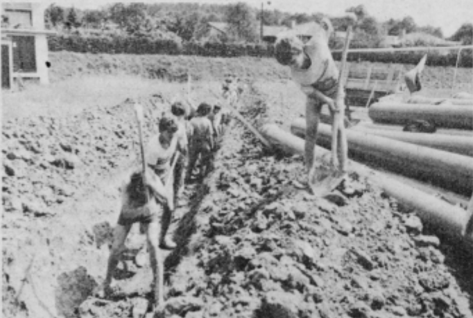
Dan pred zaključkom prve izmene so brigadirji opravili uspešen udarni dan v KS Boris Zihel v Ptuj, kjer so izkopali okoli 300 m jarka za vodovod.
