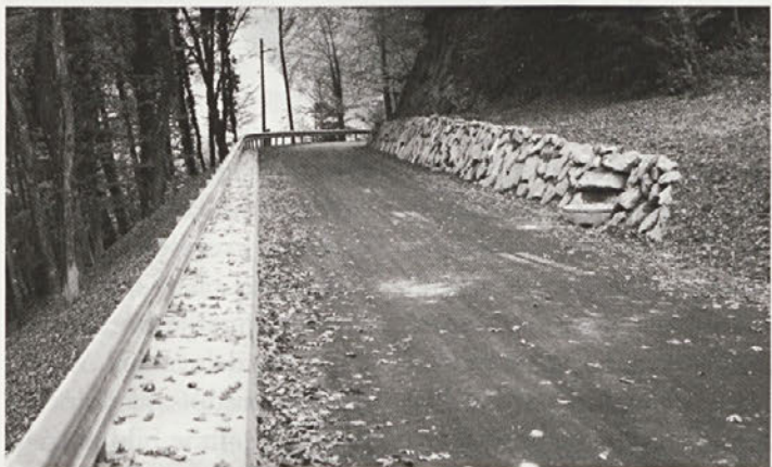
V letu 2015 je Cestno podjetje Ptuj kot izbrani izvajalec uspešno saniralo plaz na cesti Gradišča-Štuhečova hosta. Foto: RŠ
