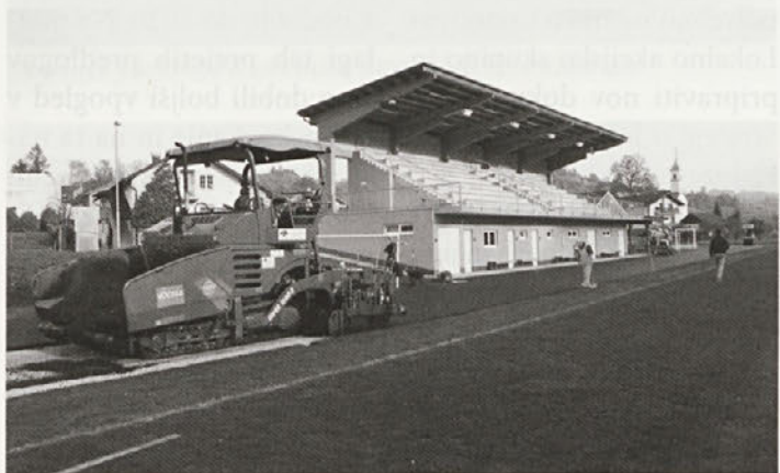
Na stadionu Cirkulane poslej tudi asfaltirana trim steza, ki bo v letu 2016 dobila še prevleko iz tartana. Foto: RŠ
