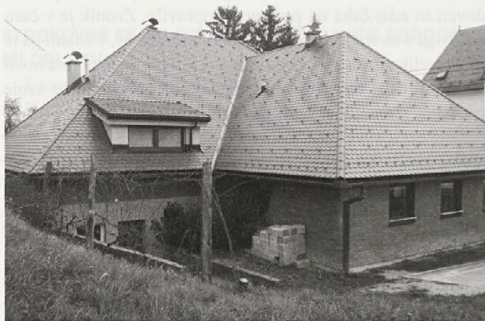
Streha na cirkulanskem župnišču je obnovljena.
