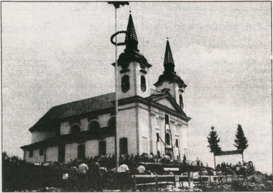
Novozgrajena žužemberška cerkev svetih Mohorja in Fortunata na dan blagoslovitve 2. jul. 1995
