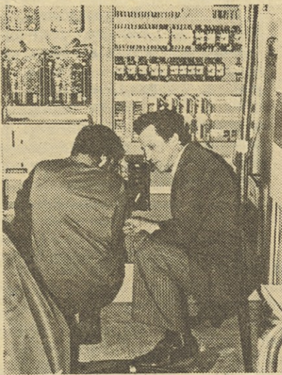
Pri montaži sodobne opreme v proizvodnjo Orojdarne so sodelovali tudi tuji monterji
