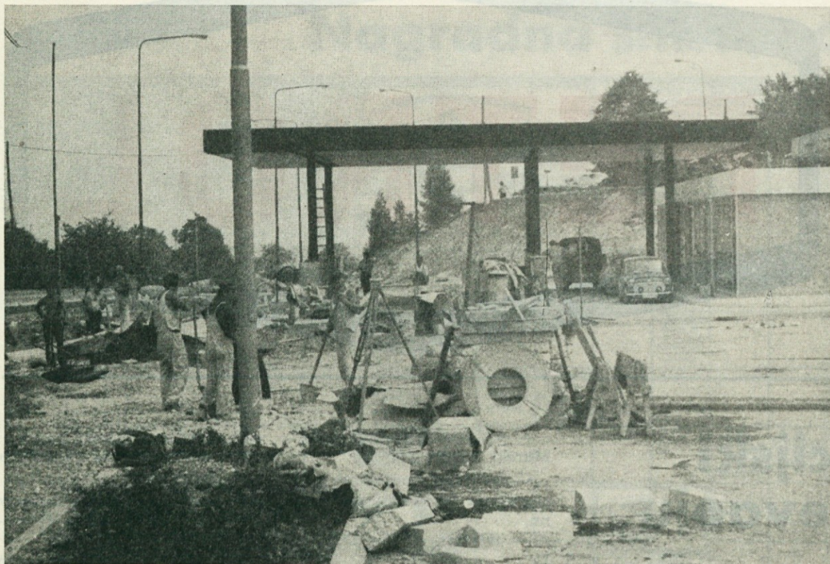
Bencinski servis Čatež med gradnjo
