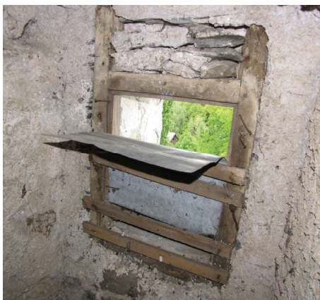
Slika 1. Odprta lina v zvoniku cerkve v Šentgotardu, ki omogoča prelet netopirjev, hkrati pa ščiti pred morebitnim naletavanjem snega in dežja. (Foto: Maja Zagmajster)
