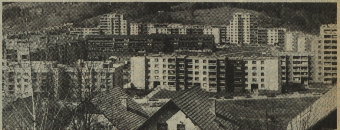
To je trenutno eno izmed večjih gradbišč na Koroškem.
