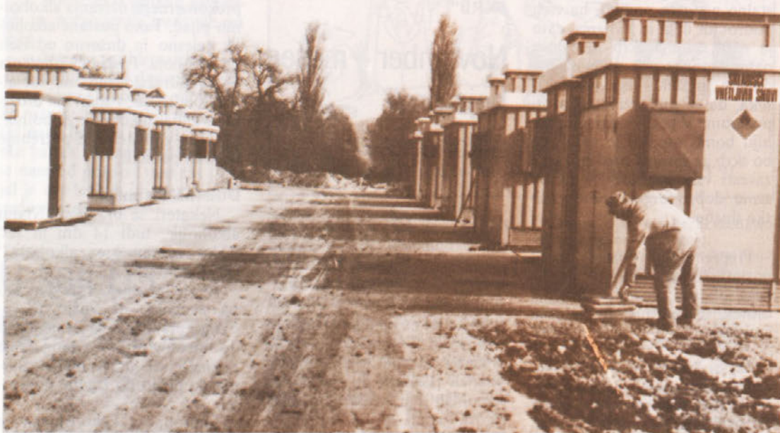
SKLADIŠČE VNETHJIVIH SNOVI: Dela pri tem skladišču so v zaključni fazi. Uporabno naj bi bilo že v mesecu novembru.
