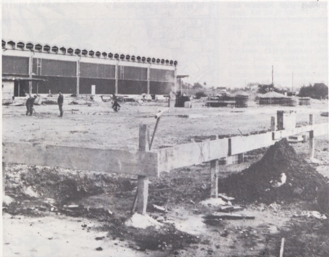
TEMELJI NADSTREŠNICE: Gradnja temeljev za nadstrešnico tečejo s polno paro. Streha pa naj bi bila gotova že v letošnjem letu.
