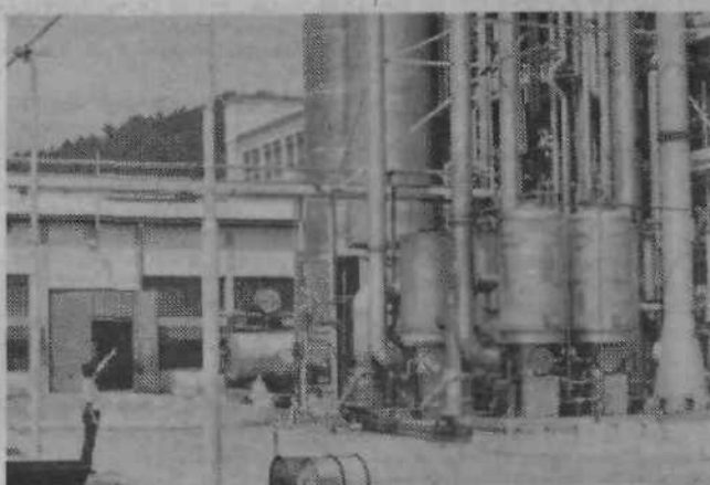
Novi obrat za proizvodnjo vodikovega peroksida v Belinki.
