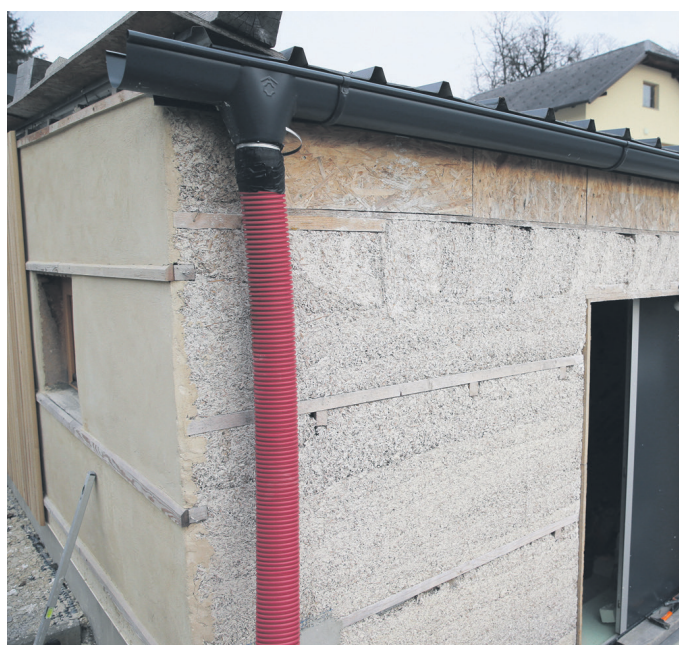
Konoplja ni edini material, primeren za rastlinski beton. Miha Lamovec je pri urejanju vrtna hiške uporabil mešanico s slonjo travo ali z miskantusom.
