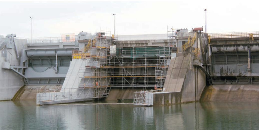
DEM bodo obnovo elektrarne in kanala začele po zaključku del na jezu Markovci, to bo predvidoma v začetku 2027. Trenutno obnavljajo peto od šestih zapornic. Foto: MZ
