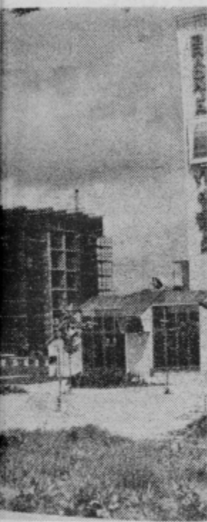
120 novih, za vselitev priprav- Dela izvaja gradbeno podjetje T. TAVCAR
