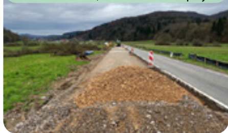
Pripravljala dela na cesti R3-647/1368 Mlačevo–Rašica, odsek Radensko polje
