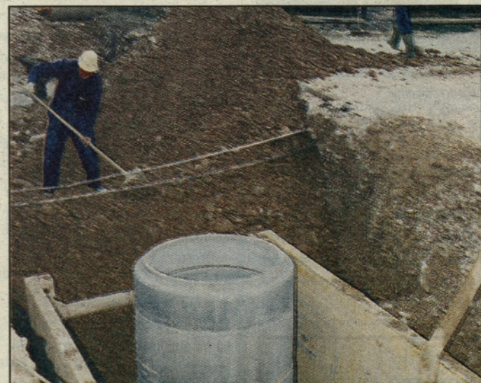
Gradnja kanalizacijskega kolektorja
