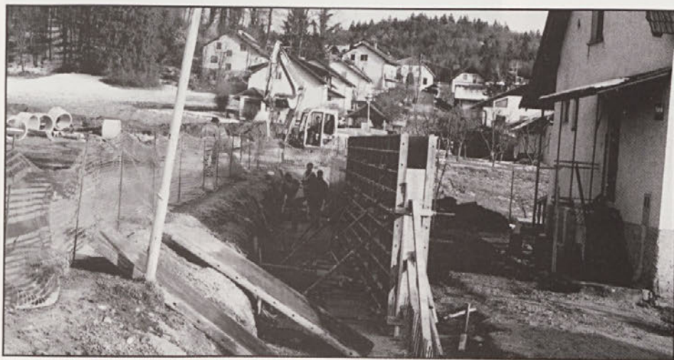
Ogromen železobetonski temelj in betonska ograja pri hiši (Kenda) za križišče cest.
