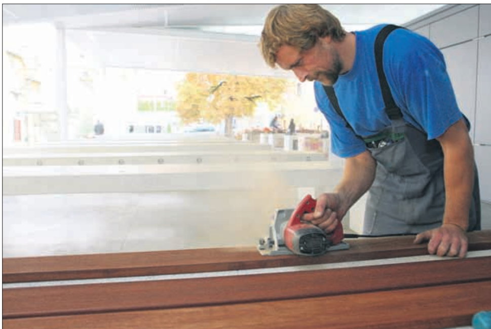
Na celjski tržnici so v tem tednu začeli nameščati lesene pode, v prihodnjem tednu naj bi na vrsto prišli še nadstreški nad ekološkim in cvetličnim delom tržnice.
