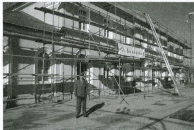
Prenavljanje poslopja na železniški postaji.
