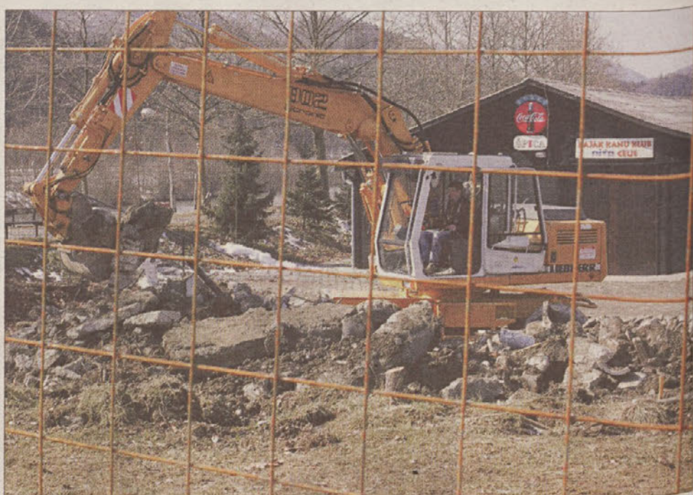
Tik pred vrati čolnarne bodo izkopali več kot tisoč kvadratnih metrov zemlje. Zadrževalni bazeni bodo dimenzije 14x6,3 metrov in globine 5,5 metra.
