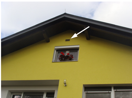
Slika 30. Luknja nad najvišjim oknom je vhod v netopirsko hiško (označeno s puščico), ki je vgrajena v izolacijski del fasade (foto: arhiv družine Škalič).
