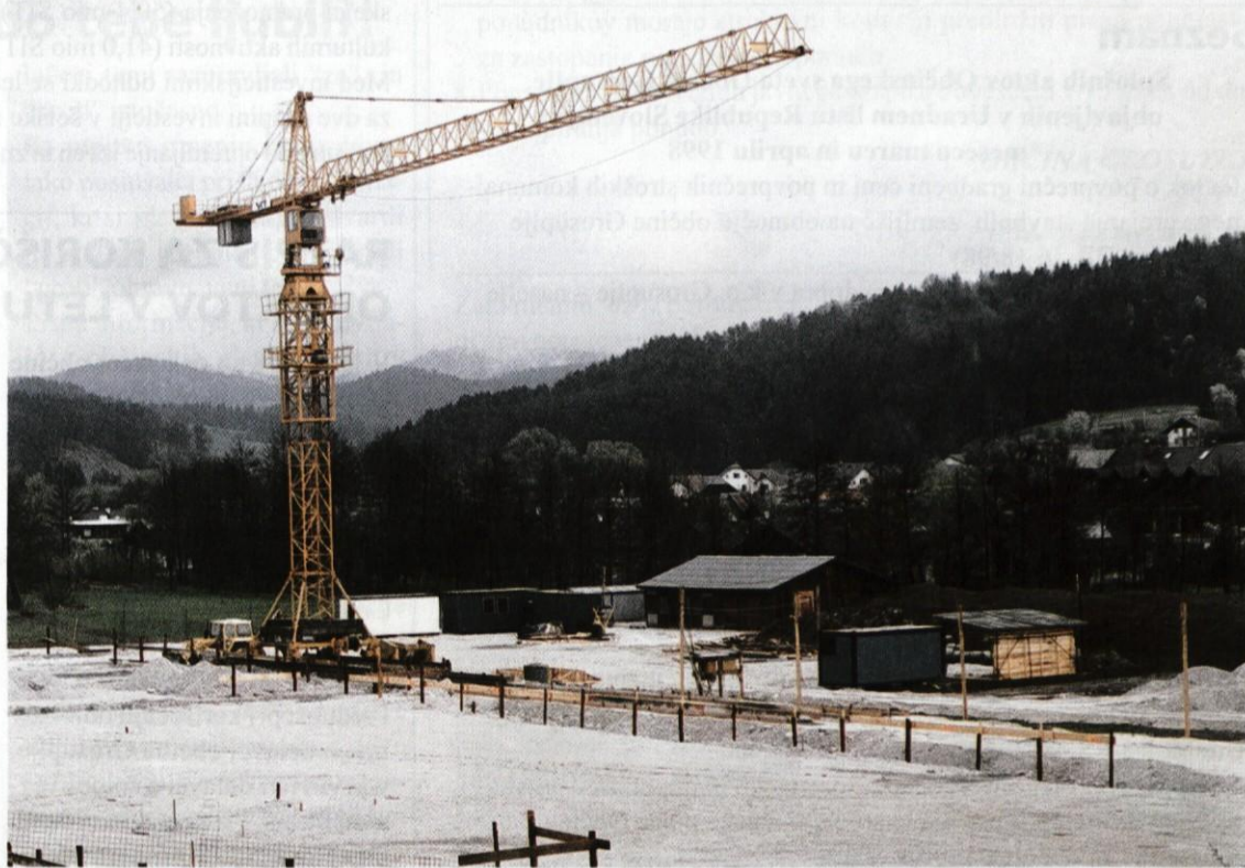
Žerjav na gradbišču nove osnovne šole, ali - začelo se je...
