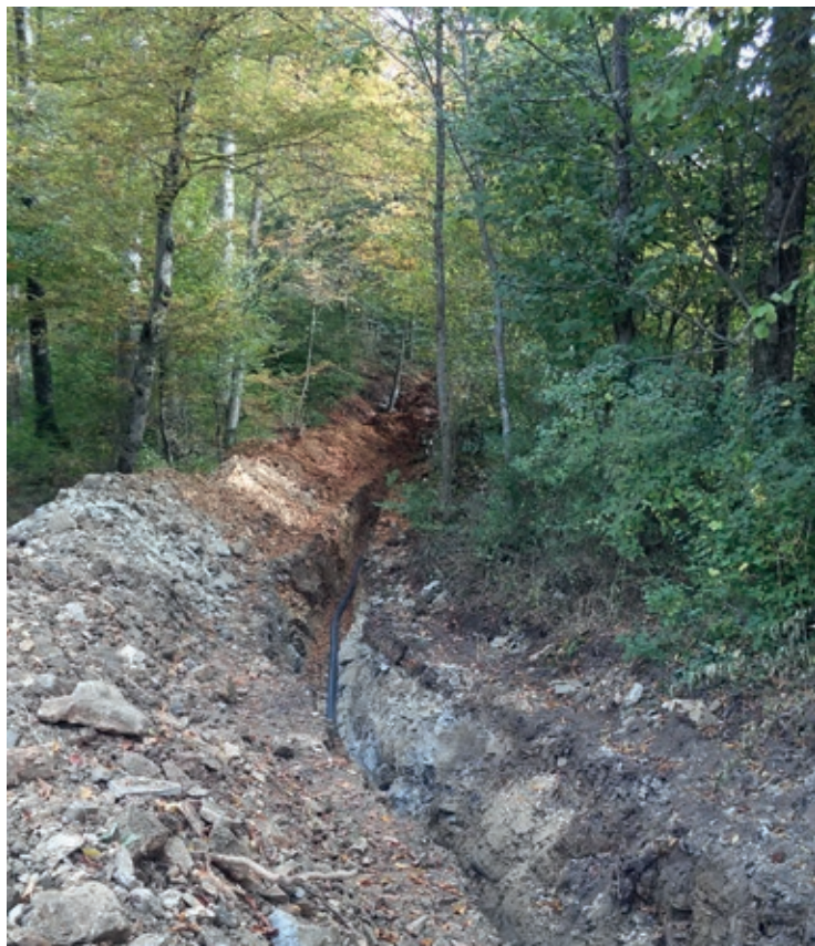
Vodovod Kremenica – izkop za polaganje cevovoda
