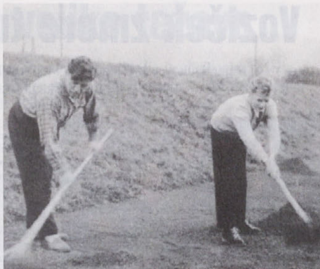
Gradnja igrišča v jami.
